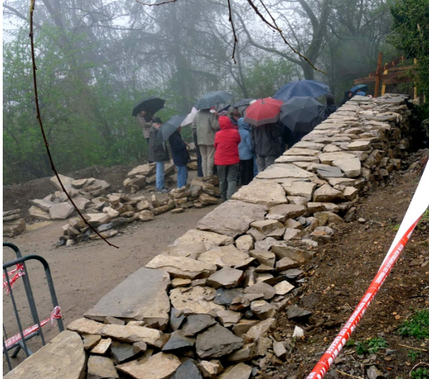
Construction d'un nouveau mur de pierre sèche Photo PSV
